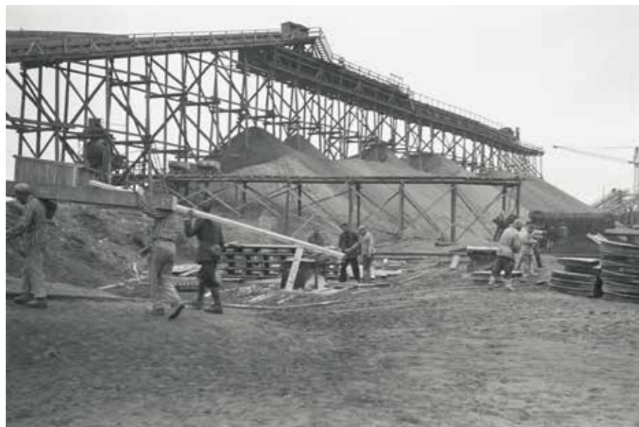
(Foto rechte Seite) Sowjetische Kriegsgefangene bei der Verladung von Spannbetonträgern für den Transport zur Baustelle, 1944
